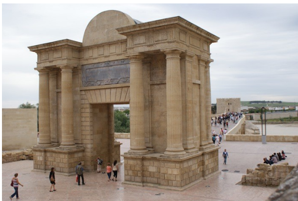
Puerta del Puente
