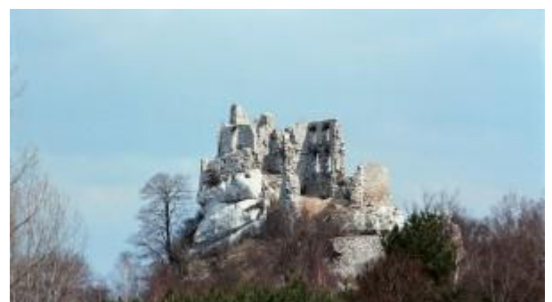
Voor de renovatie
