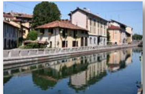
Vicolo dei Lavandai
