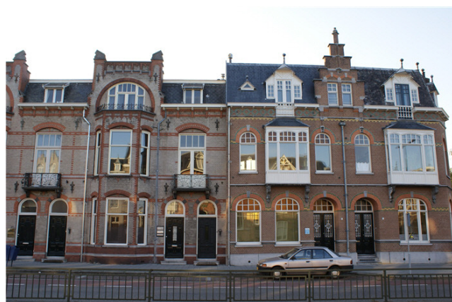
Typerende bouwstijl voor Het Zand is neo-renaissance, zoals hier aan de Koningsweg.
