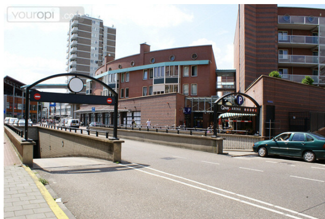
Parkeergarage Q-Park Arena ligt midden in de Bosche binnenstad.
